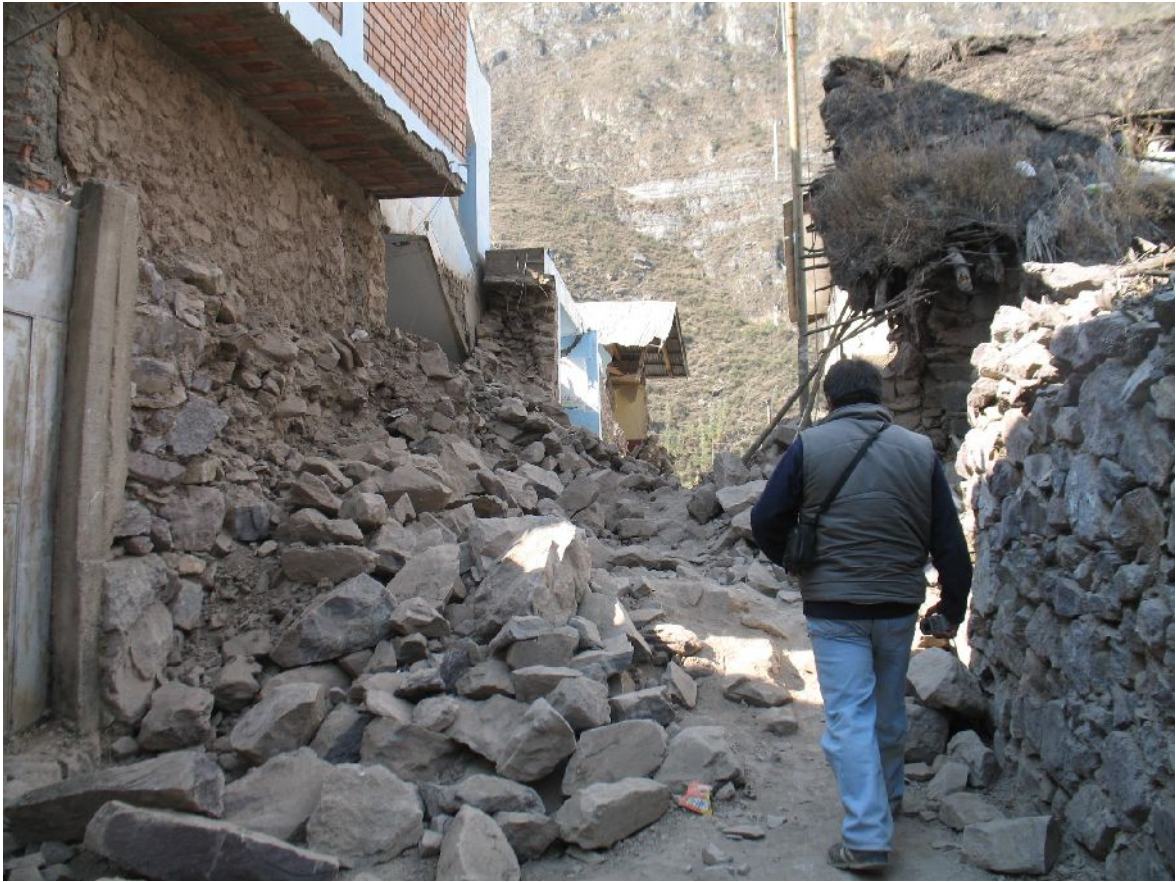
Calles de Laraos, donde se aprecia los efectos del terremoto.
